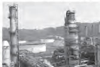
Refinería de petróleo en Esmeraldas Foto: Petroecuador
