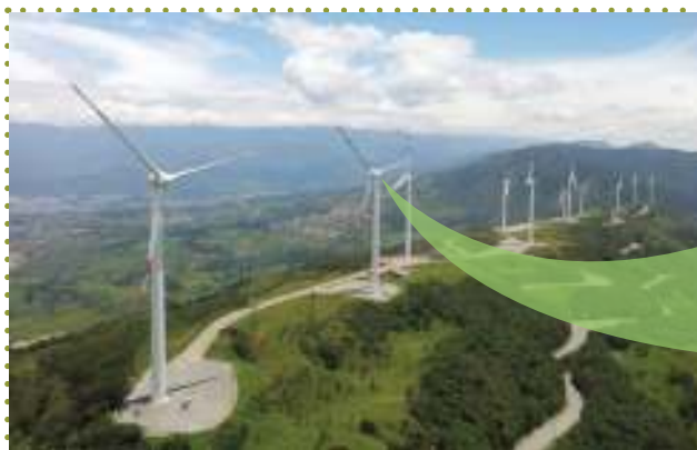
Parque eólico Villonaco, construido en la provincia de Loja, cuenta con 11 aerogeneradores de 100 m de alto.
