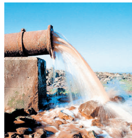
Vertido de aguas contaminadas.
