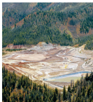
En los rellenos sanitarios se producen lixiviados.
